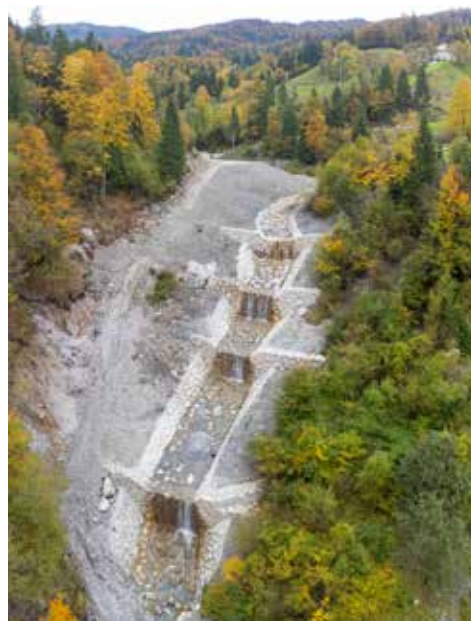
Zaledje PB Franja po sanaciji
