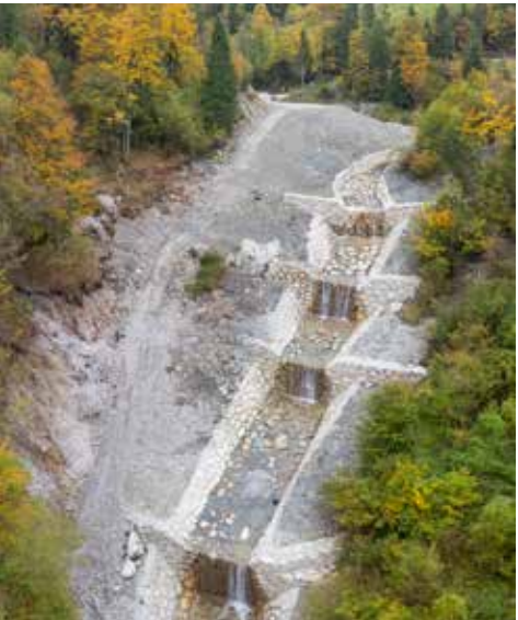
Sanacija plazu nad Franjo se bo v skladu s pogodbo z izvajalskim podjetjem Zidgrad zaključila do konca oktobra.
