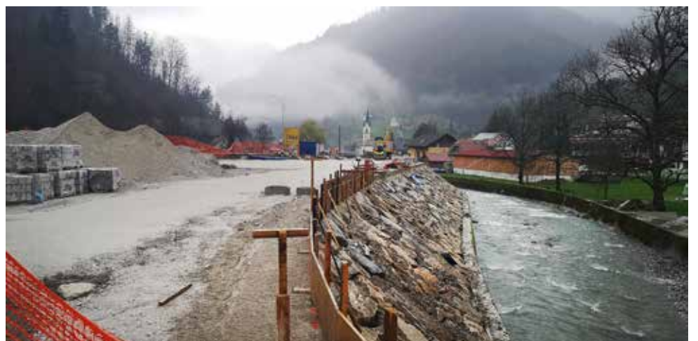
Izgradnja opornega zidu ob Cerknici ne bo vplivala na uporabno površino avtobusne postaje.
