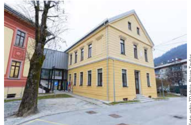
V Idriji so prenovili stavbo »avstrijskega« dela starega zdravstvenega doma.
