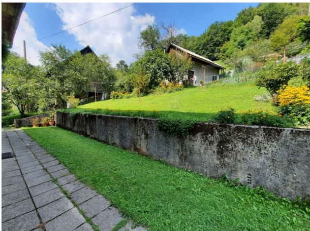
Slika 11: pogled na površine za obstoječo hišo, kjer se načrtuje prizidava, in na obstoječi pomožni kmetijski objekt.
