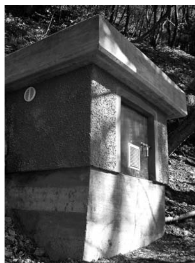
Nov zbirni jašek z usedalnikom in nadzemnim delom pod pregrado
