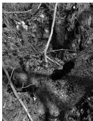
Obstoječi zajem pred sanacijo
