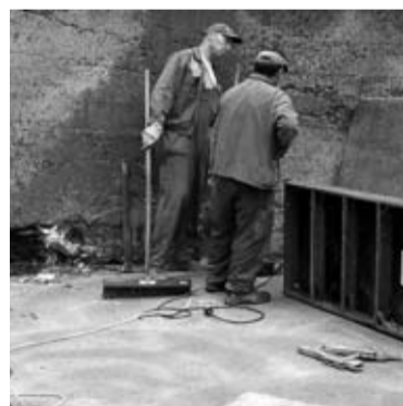
Sanacija obstoječih sten bazena
