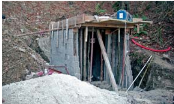
Objekt vodooskrbnega sistema Planina med gradnjo v novembru 2011
