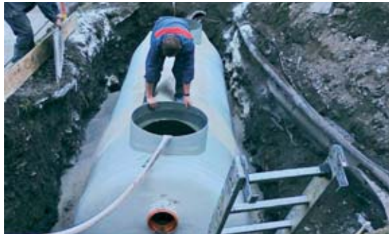
Vgradnja maščobolovilnika na čistilni napravi Cerkno
