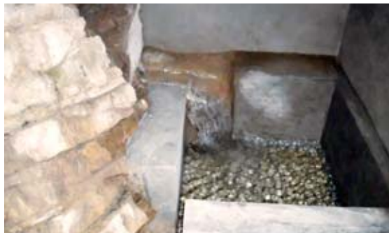
Notranjost obnovljenega objekta vodooskrbnega sistema Bukovo
