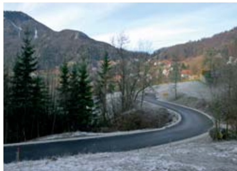
Obnova ceste na relaciji Vrh Križa–Jesenica
