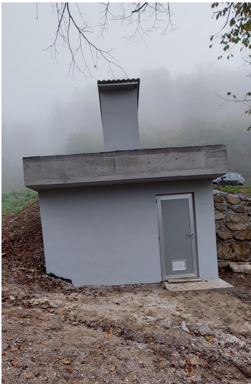
Objekt vodohrana Travnik po izgradnji
