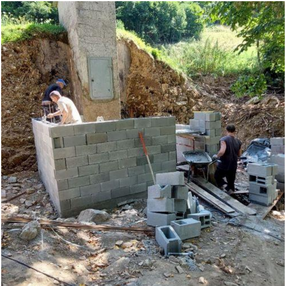
Vodohran Travnik med gradnjo
