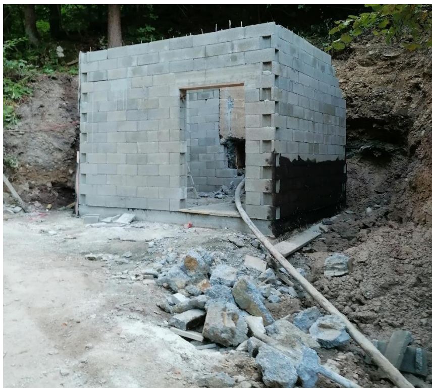
Gradnja novega zbirnika z vhodom s ceste
