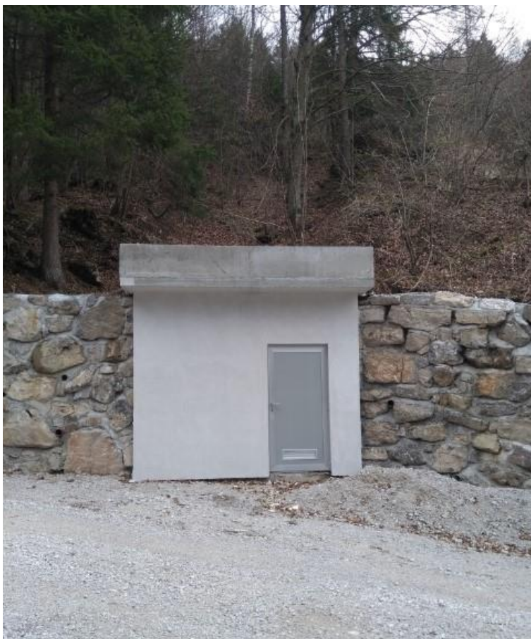
Objekt zbirnega zajetja po izgradnji
