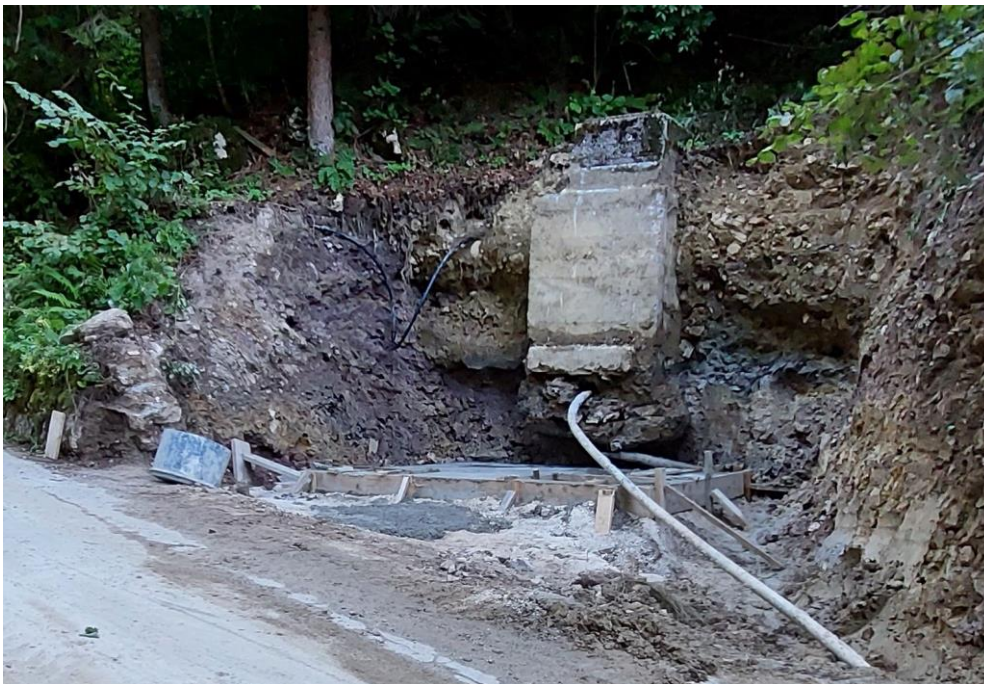
Izkop za novi objekt z vhodom s ceste
