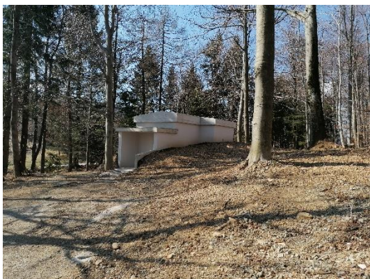
Zunanost novega vodohrana Ravni vrh
