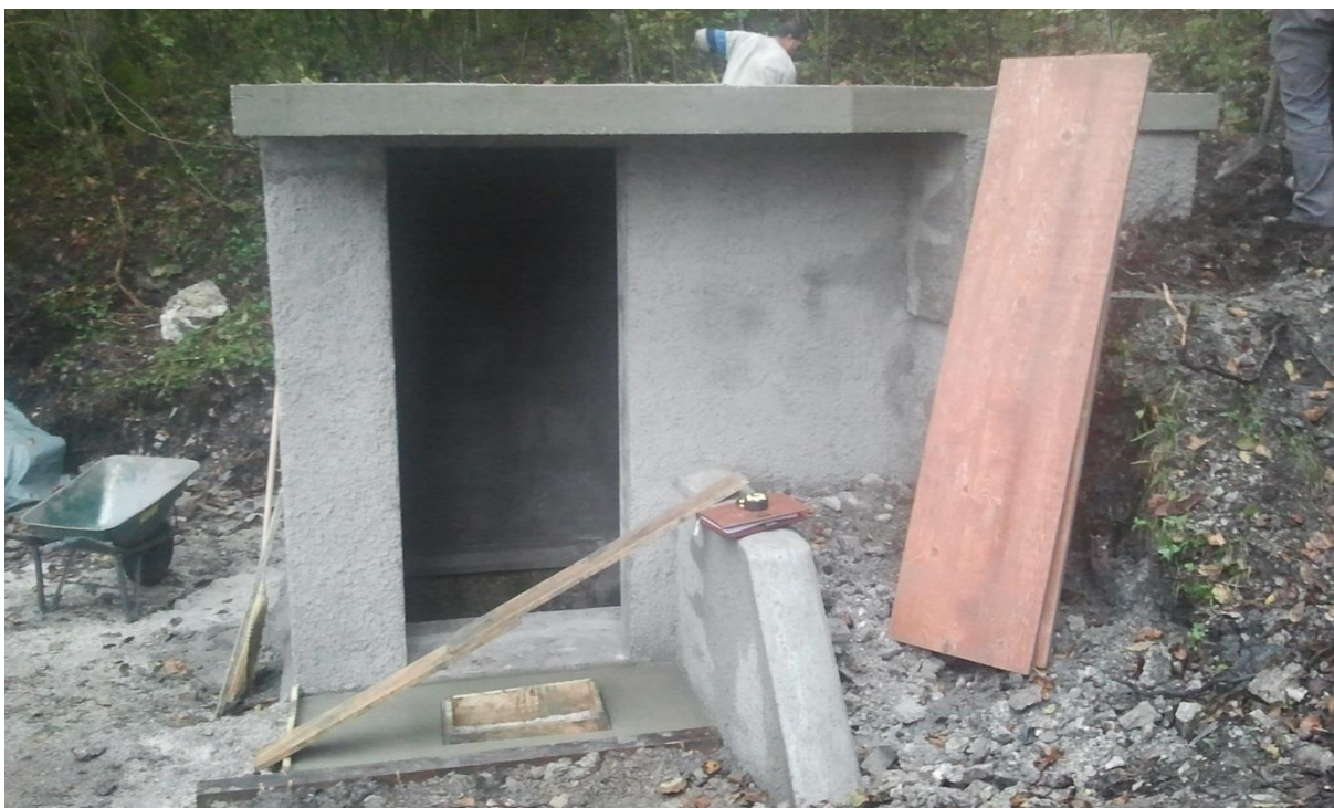
Gradnja novega prizidanega suhega dela
