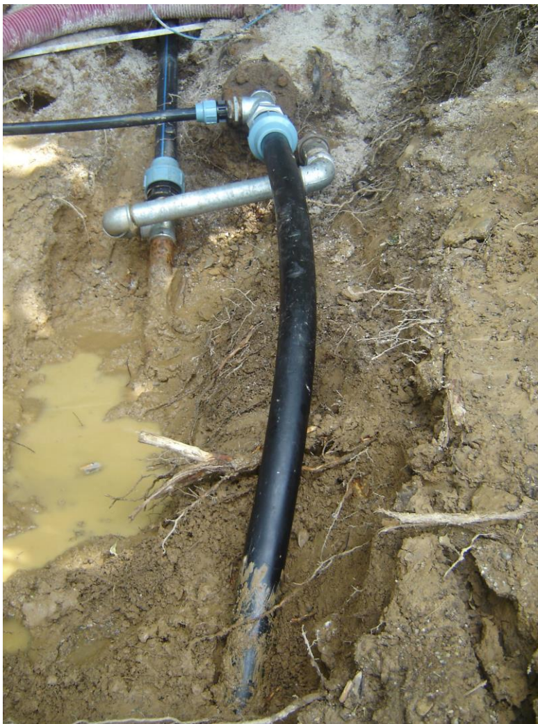
Dotrajan železni cevovod se je umaknil novemu iz alkatena materiala
