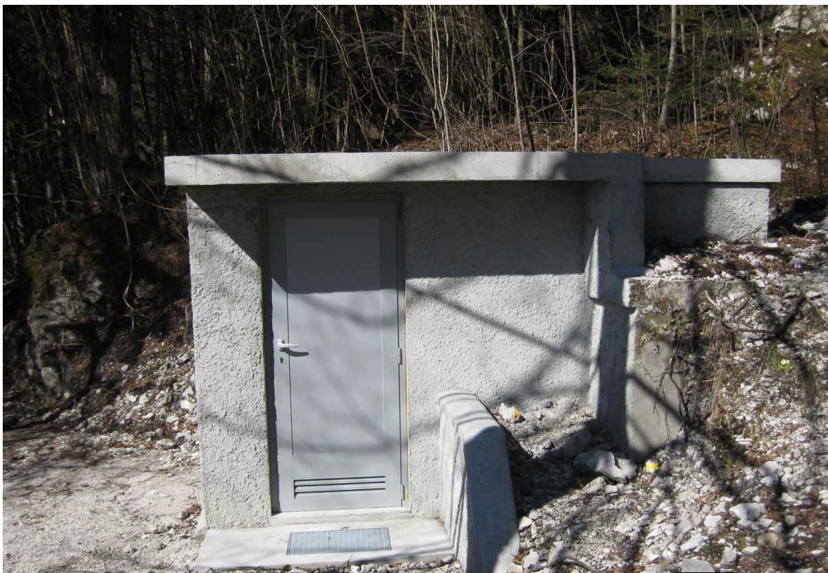
Vodohran po sanaciji
