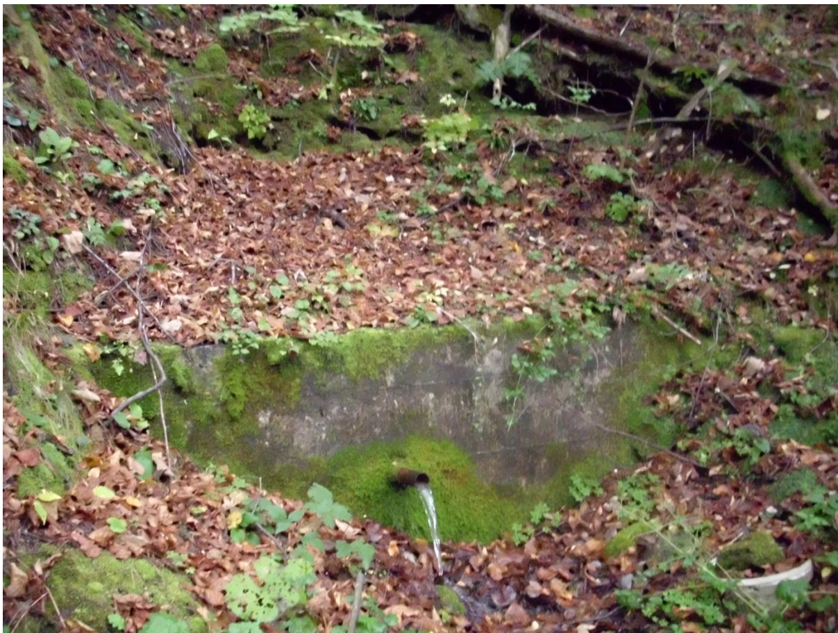
Zajetje za črpališče v Ravnah pred sanacijo
