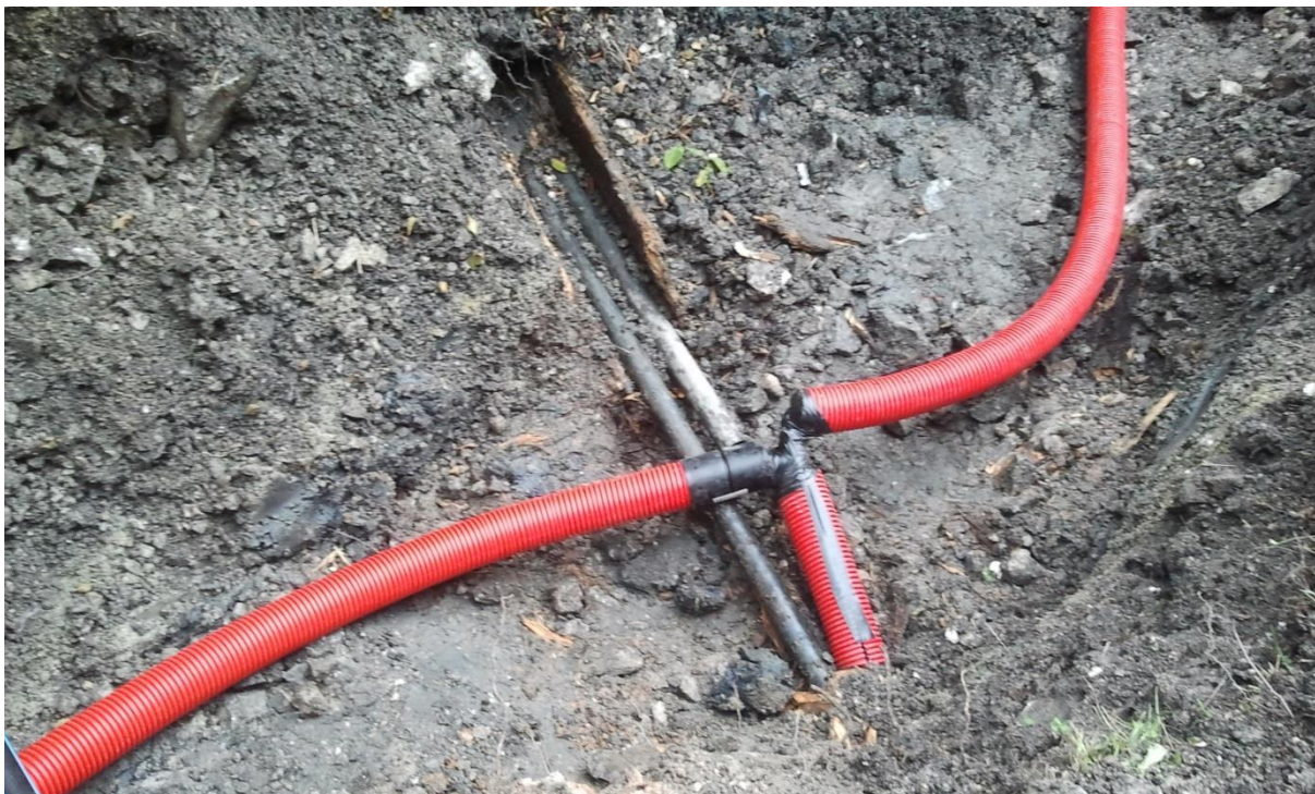
Prevezave na napajalnem vodovodu
