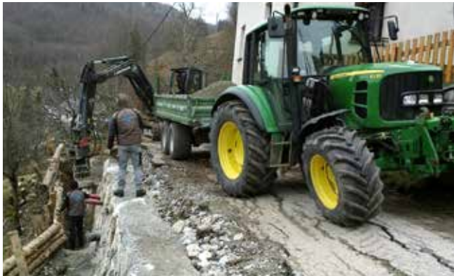
Sanacija ceste v vasi Gorje
