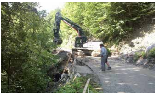
Sanacija udorov na cesti Laharna–Police
