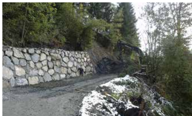
Sanacija odseka ceste Jesenica–Kojca
