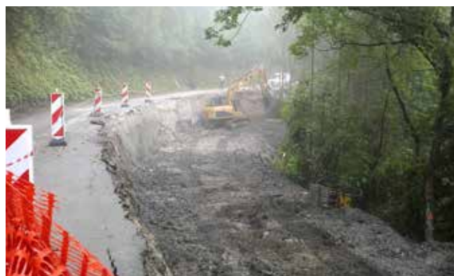
Sanacija podpornega zidu in preplastitev vozišča v vasi Spodnje Jazne
