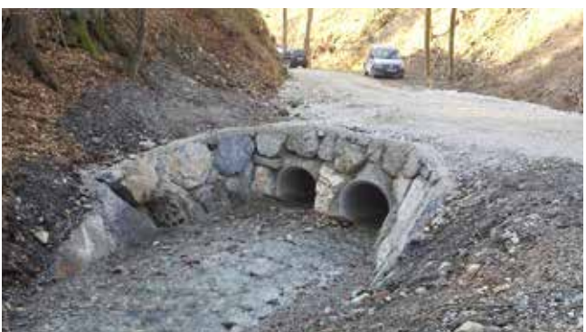
Rekonstrukcija ceste Mrovljev grič–Joškovec
