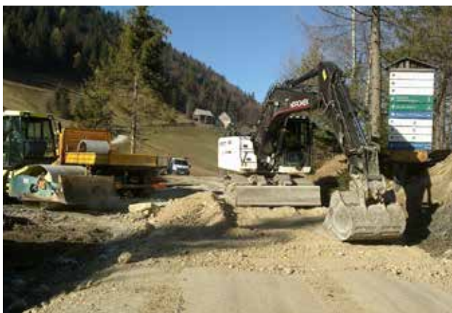
Ureditev odvodnjavanja in sanacija posedka na cesti Razpotje–Čumar, Novaki
