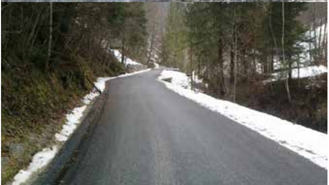
Sanacija ceste Pot v Čelo
