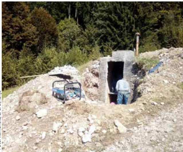
Vodohran Poče (zgornji) v času sanacije
