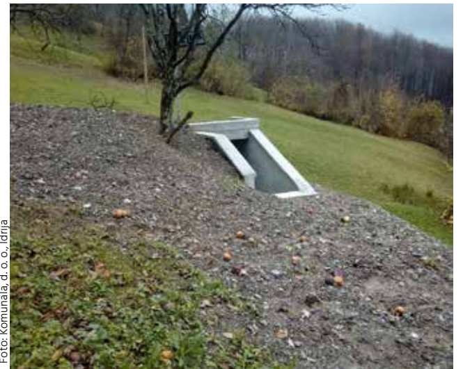
Raztežilnik v Laznici po končani sanaciji
