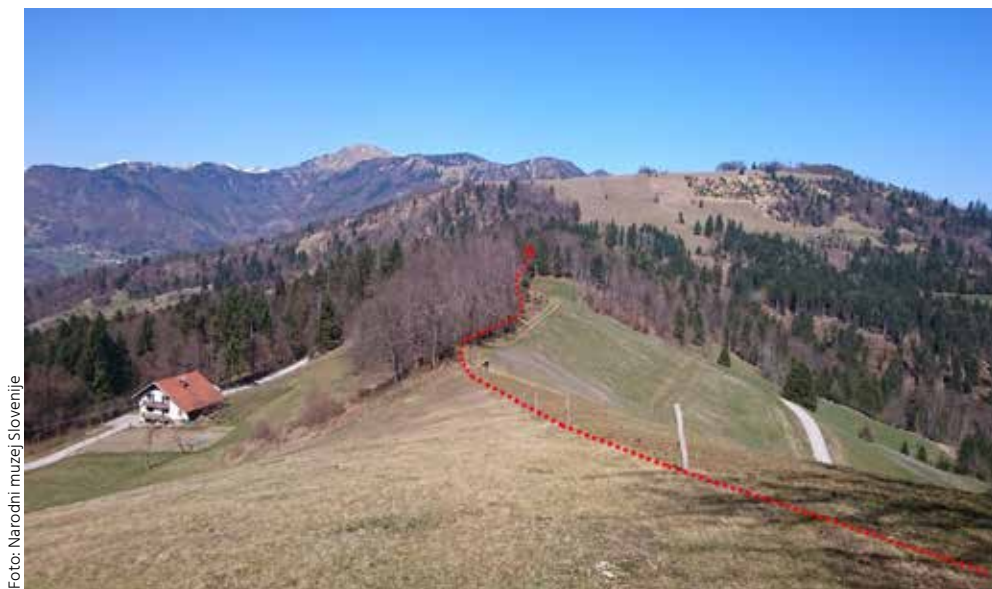
Potek nedavno dokumentiranega zapornega zidu nad Podplečami
