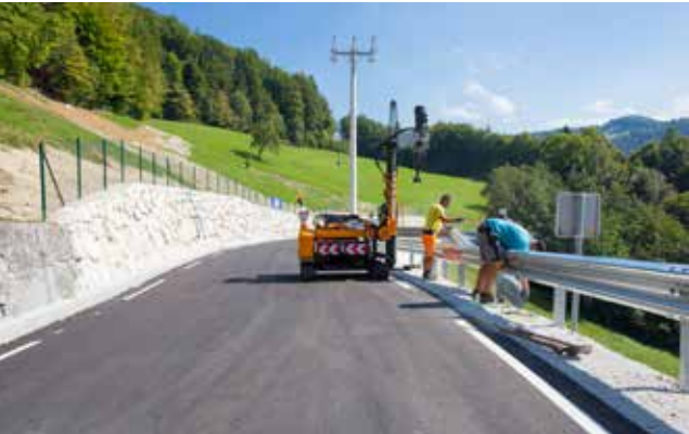
Sanacija plazu in cestišča v Novakih
