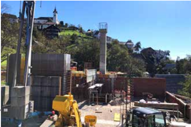
Gradbišče novega gasilnega doma v Otaležu
