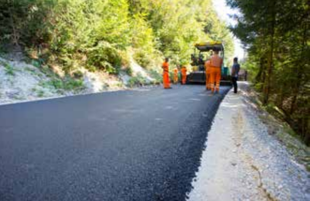
Asfaltacija dela ceste na Črni vrh
