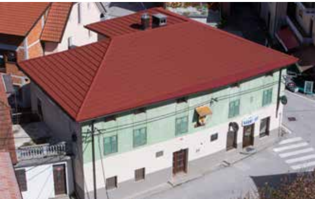
Preplastitev Ceste OF v Cerknem (zgoraj) in novo ostrešje na “Gabrijelovi” hiši v Cerknem
