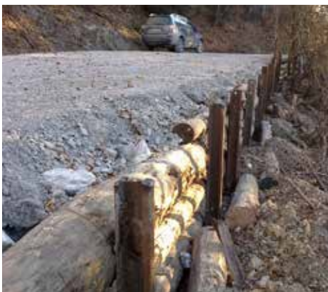
Sanacija, izvedena z železniškimi tirnicami in hlodovino
