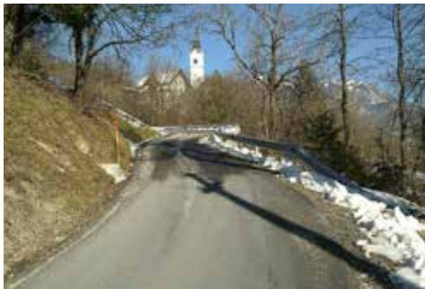
Prenovljen odsek ceste Cerkno-Zakriž
