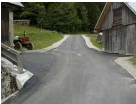
Asfaltacija odseka Dolenji Novaki-Robidnica
