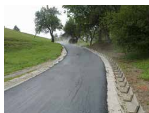
Rekonstrukcija odseka Mrovljev grič-Joškovce
