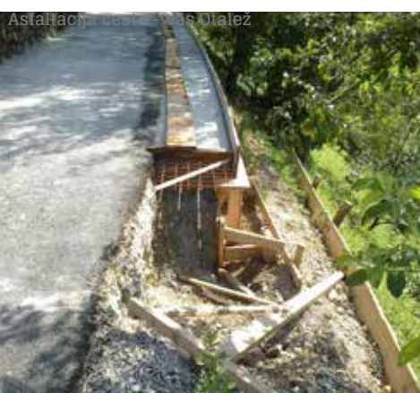
Rekonstrukcija ceste Otalež-Poklonar
