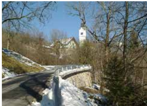
Pogled na nov podporni zid
