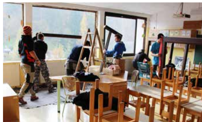
Poleg oken bodo prenovili tudi talno izolacijo sten, zamenjali bodo svetila ter dotrajano streho na severnem stolpiču razredne stopnje.
