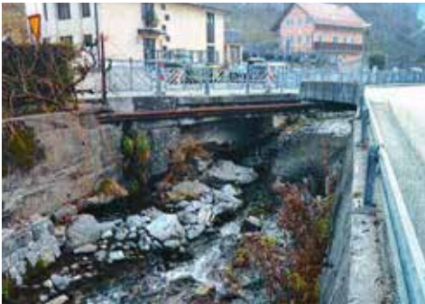
Most pred začetkom obnovitvenih del
