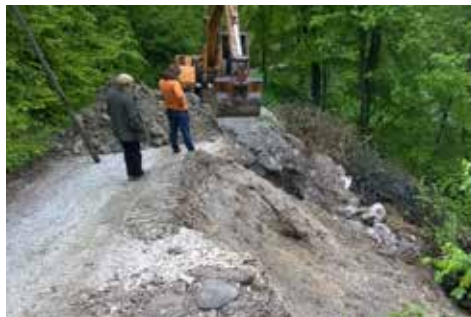
Sondažni izkop plazov Podnjivč
