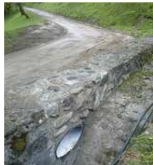
Iztok in končno stanje saniranega plazov
