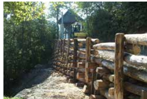
Zaključen spodnji del sanacije
