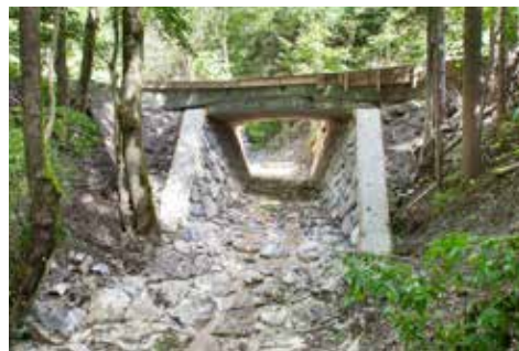
Sanacija mostu v Gorjah
