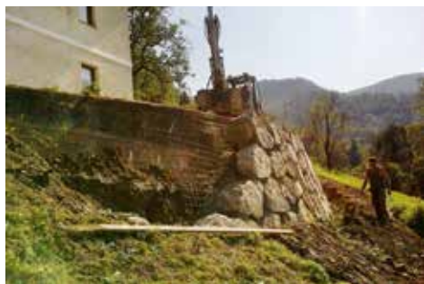
Postavitev novega opornega zidu na cesti med Črno Mlako in Šebreljami
