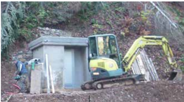
Gradnja nadzemnega objekta zajetja v Šebreljah
