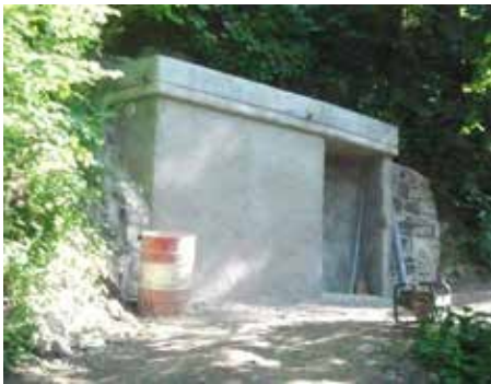
Novo zgrajeni objekti zajetij v Otaležu
