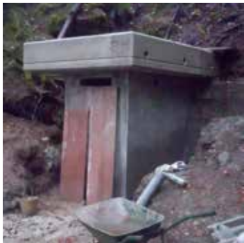
Nadzemni objekt zajetja v Spodnjih Ravnah med gradnjo
