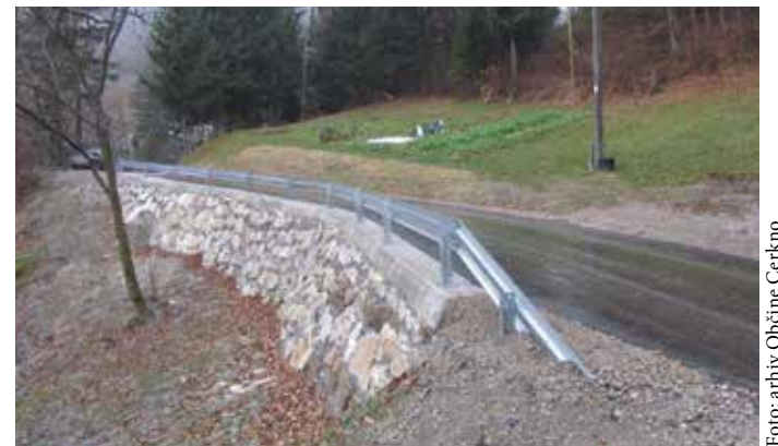
Saniran cestni odsek v Novakih (Zanjivč).
