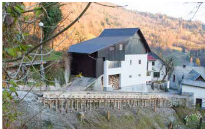
Sanacija ceste v Orehku
