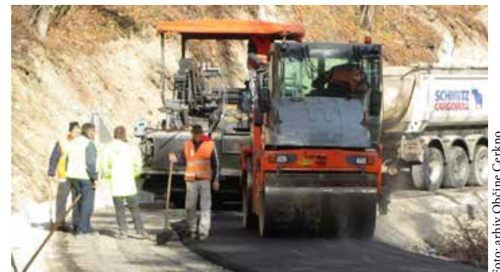
Rekonstrukcija ceste Orehek - Jesenica
