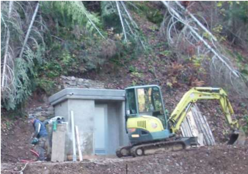
Gradnja nadzemnega objekta zajetja v Šebreljah
