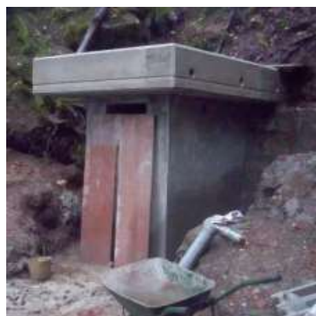
Nadzemni objekt zajetja v Sp. Ravnah med gradnjo
